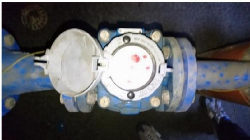
Esempio n. 2 Quadrante illeggibile del contatore dell'acqua - quadrante sfocato
